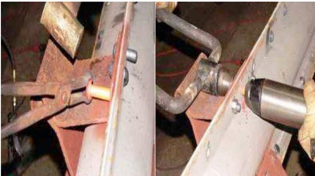
Nella foto a colori le fasi di inserimento e ribattitura del chiodo incandescente; nel disegno, le medesime fasi in sequenza - da sn. a dx.: chiodo inserito; chiodo in ribattitura; chiodo ribattuto che presenta 2 teste emisferiche.
